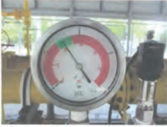
รูปภาควัดแรงดันหลังออกจากอุปกรณ์ปรับลดแรงดัน
